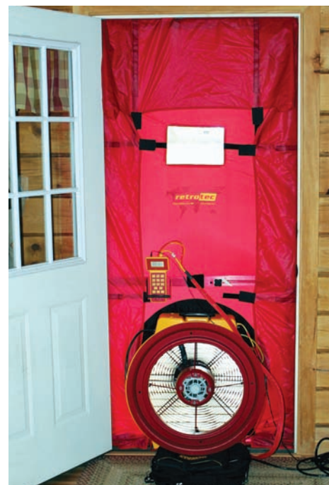
Blower door interior
